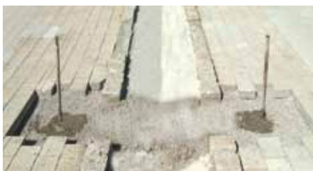
Fertig gesetzte Injektionspfähle
