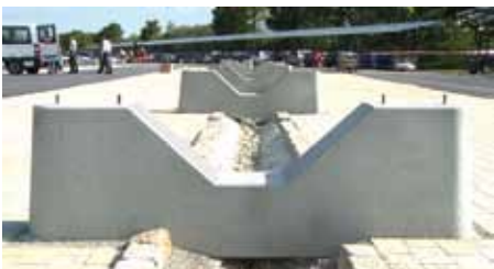
Fertigteil Fundament gesetzt und ausnivelliert
