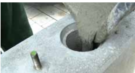
Ausgießen der Fundamente mit Vergussmörtel
